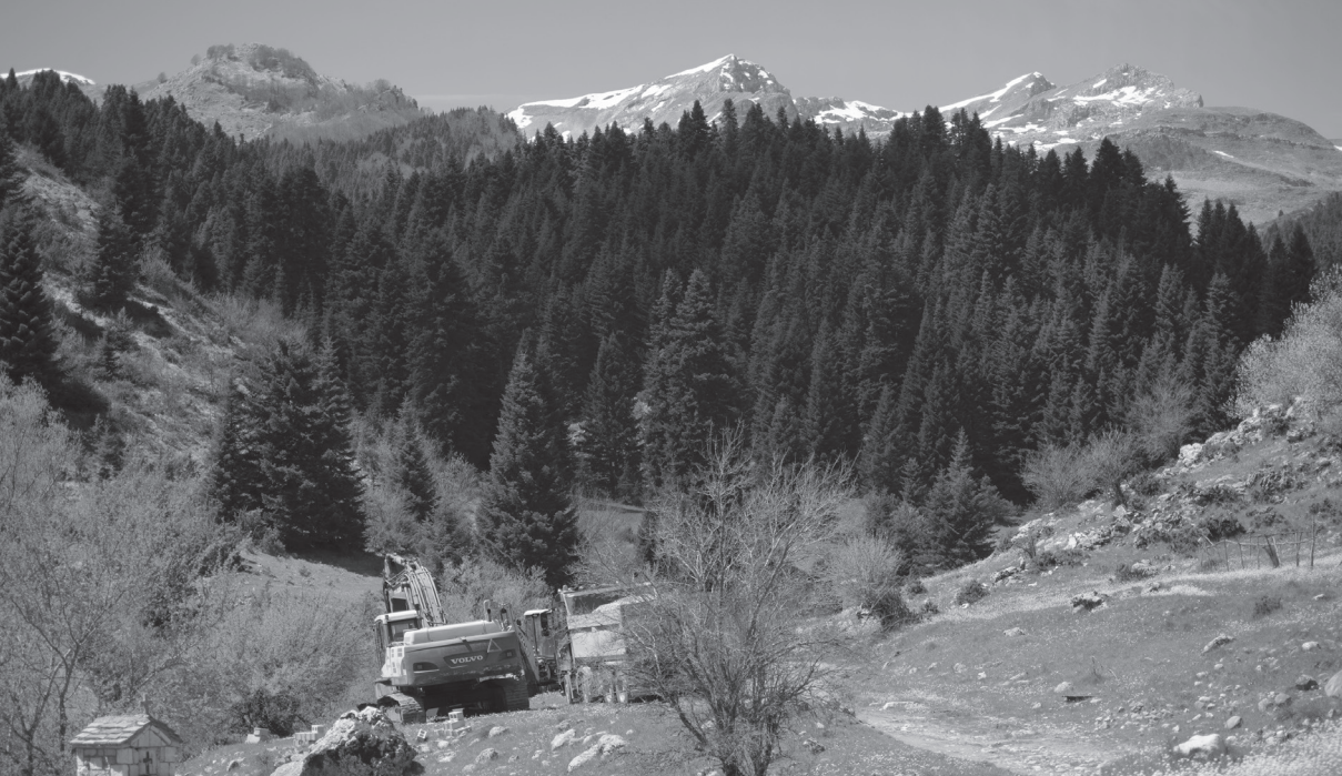
Άνοιξη 2025, Χαλίκι Ασπροποτάμου. Μηροστά, τα μηχανήματα του εργολάβου. Πίσω, η τοποθεσία «Ελατάκια», όπου σχεδιάζόταν η κατασκευή μικρού υδροηλεκτρικού εργοστασίου στο ρέμα Καρραρία. Φωτό / ΕτΑ.
