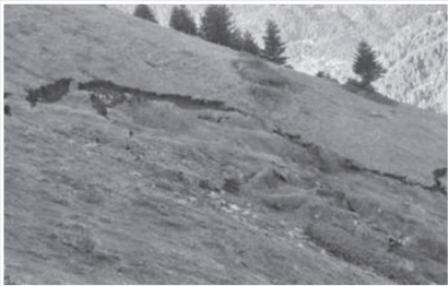
Κατολισθήσεις, μετά τις πλημμύρες, στο Βοϊδολίβαδο, στο σημείο όπου προβλέπεται η τοποθέτηση 11 ανεμογεννητριών.
